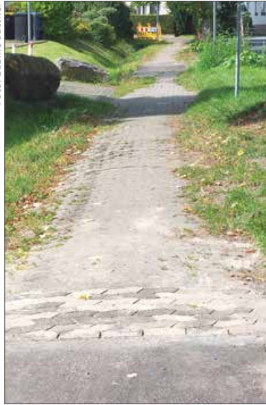
Zwischen dem neuen Asphalt (unten) und dem noch brüchigen Teil des Radweges (oben) an der Konrad-Adenauer-Straße wurden die unterschiedlichen Beläge mit einigen Reihen neuer Steine angeglichen.
