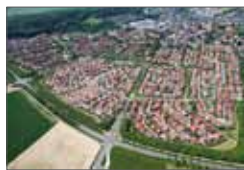
Mittelfeld von Süden
